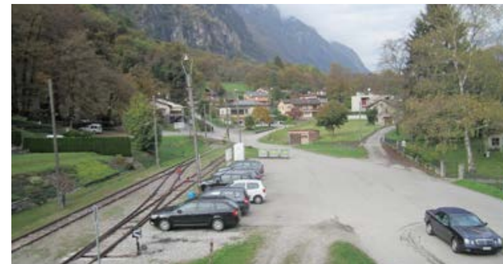
151 Cama. L'area del parcheggio e i binari che verranno rimossi per la costruzione della strada di quartiere
