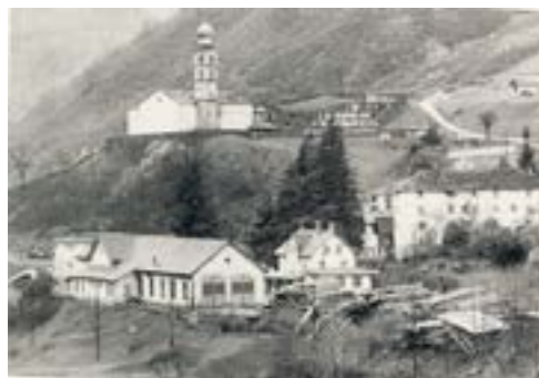
126 Mesocco. Foto storica della stazione vista da nord
