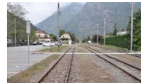
143 Grono. Stazione vista da sud.
