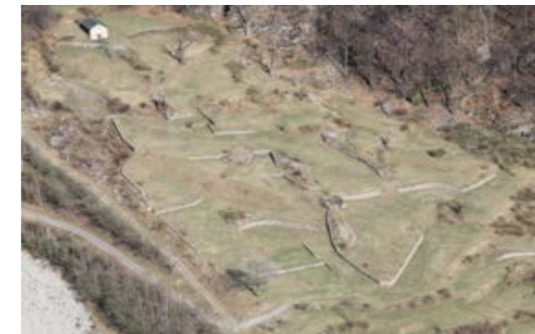
89 Soazza. Lom-Dang. Terrazzamenti restaurati
