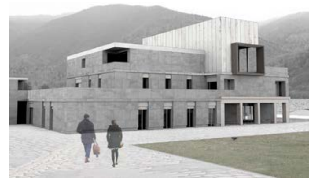
163 Roveredo. Edificio multiuso, vista della facciata sud-est
