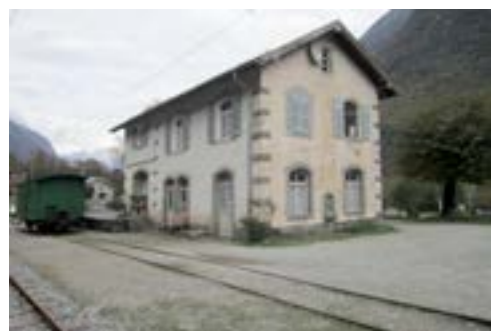
123 Cama. Stazione vista da sud
