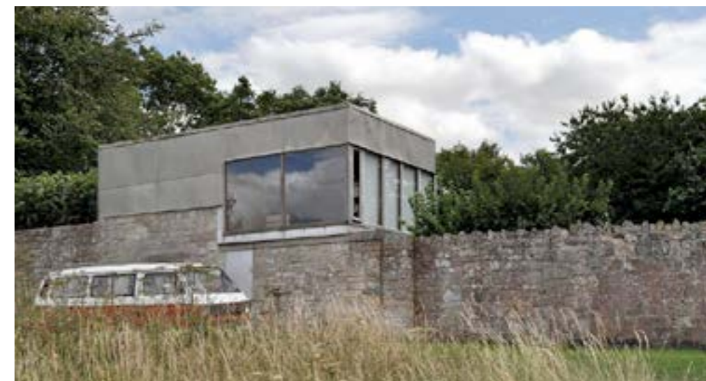
137 Upper lawn pavilion, Fonthill Estate, Tisbury, Inghilterra, Alison and Peter Smithson, 1962. La parte nuova è appoggiata sul muro esistente.
