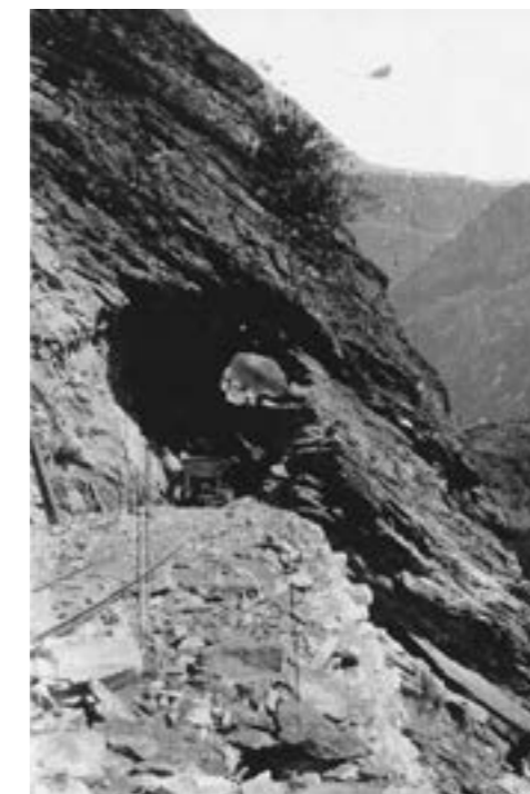
8 Soazza, Pont del Sass. Galleria in costruzione
