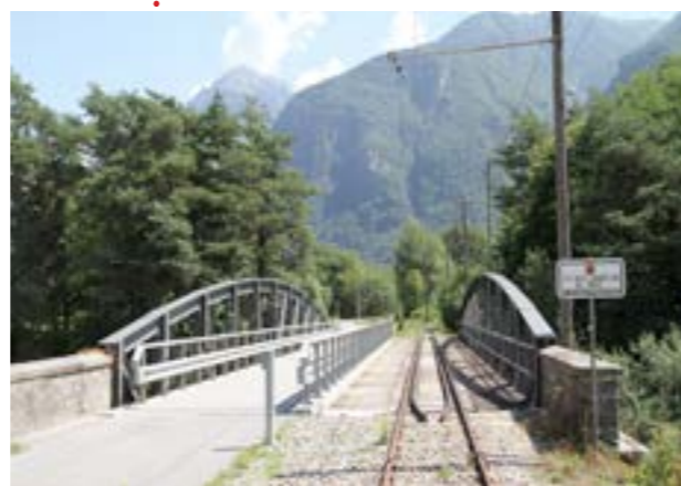
39 Grono. Ponte in ferro sulla Calancasca
