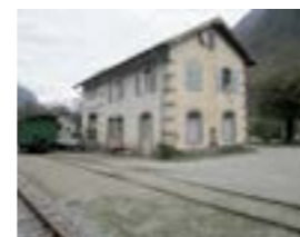
108 Cama. Il piano terra della stazione è sfruttato come deposito, mentre il primo piano viene occupato saltuariamente da associazioni comunali per riunioni o attività di svago
