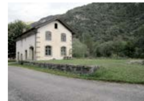
109 Lostallo. L'edificio è ancora in buono stato. Nei suoi locali è installato un ufficio tecnico privato.
