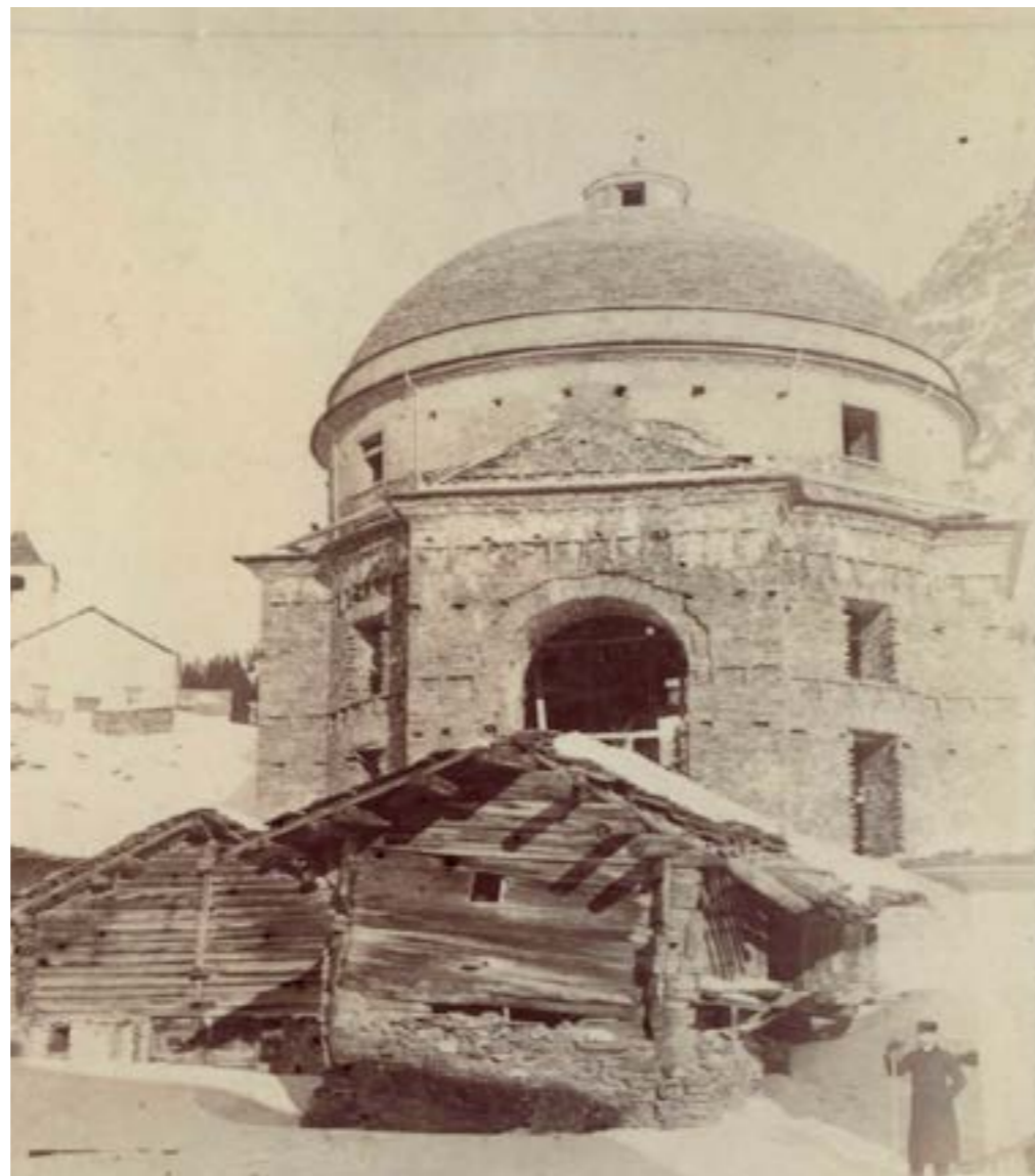
28 San Bernardino. Chiesa rotonda in costruzione, 1892. Autore della foto: Emilio Tagliabue, Milano
